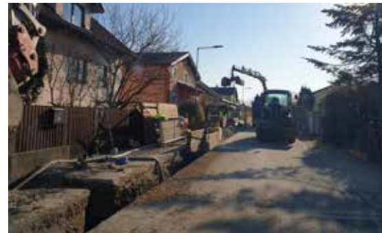
Die Arbeiten an der Wasserleitung wurden in Mitterdorf in der Bahn- und Gartenstraße bis zur Gramatneusiedler-Straße fortgesetzt. Auch hier besteht kein Anschlusszwang.
